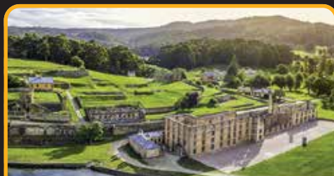
亚瑟港监狱遗址 Port Arthur*
